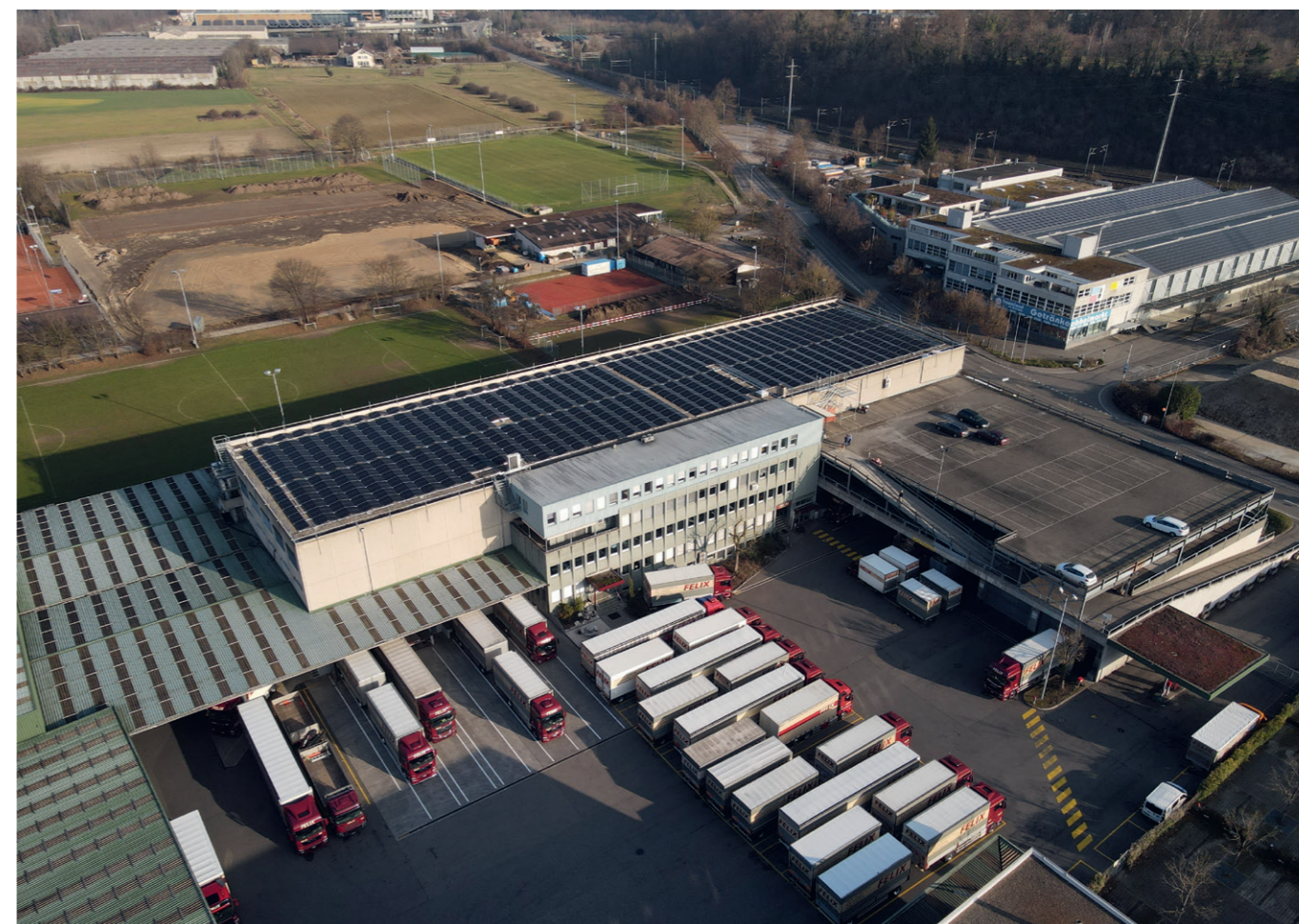
Die Anlage in Arlesheim produziert 376 000 Kilowattstunden Strom. Damit können gegen 60 Prozent des gesamten jährlichen Strombedarfs des Gesamtareals mit eigener Solarenergie gedeckt werden. BILD: FELIX TRANSPORT AG
